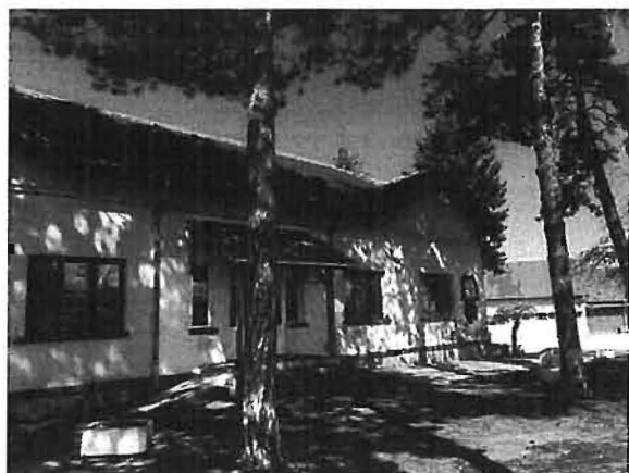
Фотографије фасада објекта бр.1
