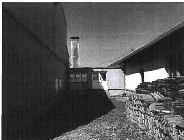
Фотографије фасада објекта бр.9
