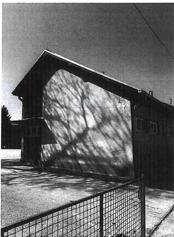
Фотографије фасада објекта бр.3
